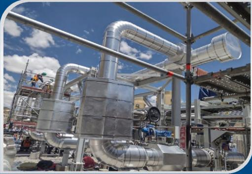
Aislamiento Térmico de ductos con lana mineral, recubierto con planchas de acero inoxidable.
