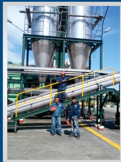
Aislamiento Térmico de equipos y tuberías con lana de vidrio, recubierto con planchas de aluminio.
