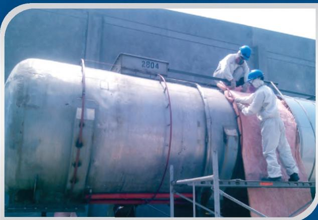
Aislamiento Térmico de ductos y accesorios (Codos, Tees, Reductores, etc.) con cañuelas de fibra de vidrio, recubierto con Planchas Galvanizadas y Ducto de distribución de Aire.
