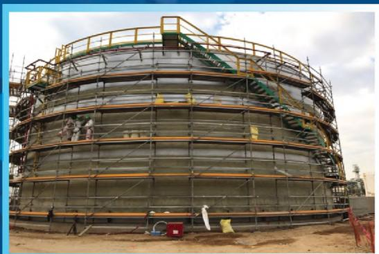
Aislamiento Acústico con Placas Composite Conformado de 58 mm esp. y Composite Barrier de 3 mm esp. sellado con Poliuretano de 36 Kg/m<sup>3</sup>. Reducción de 14 dB.
