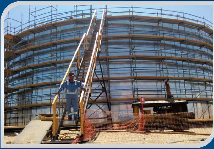
**Aislamientos Térmicos de tanques con Lana Mineral de 100 kg/m3 densidad recubiertos con Planchas de Aluminio ondulada.**
