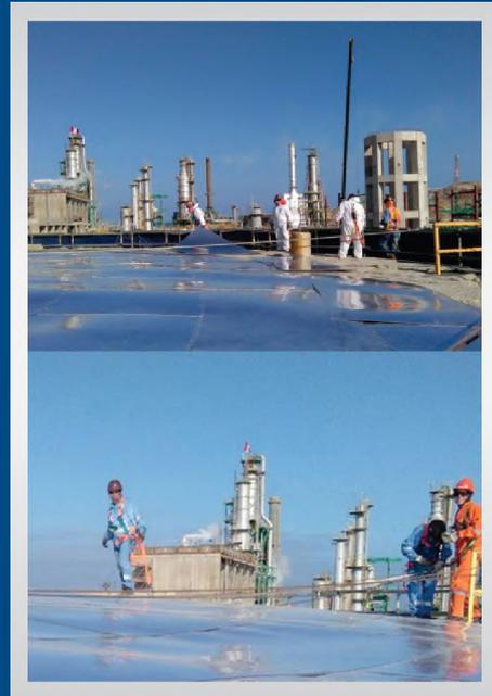
**Aislamiento Térmico de tanques de fermentación con poliuretano, recubierto con planchas de aluminio.**
